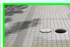
熱交換井施工箇所
