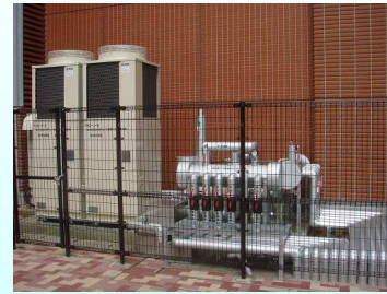
室外機設置状況
