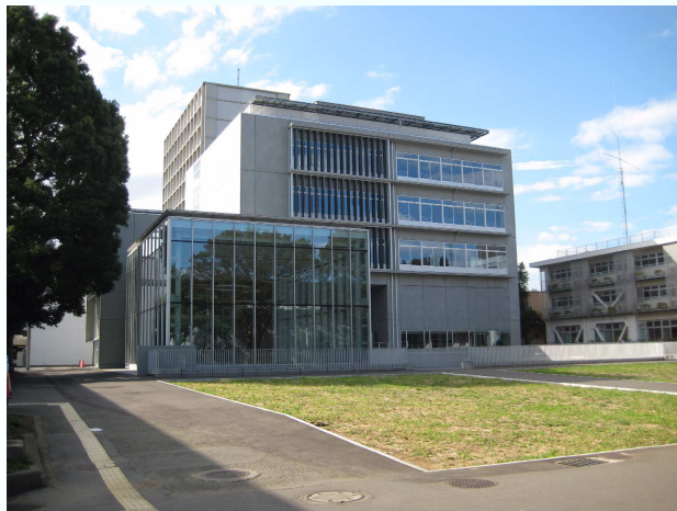
大学施設の外観
