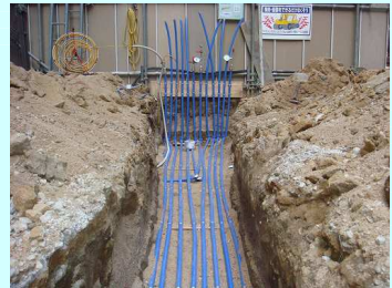
熱交換パイプ埋設状況
