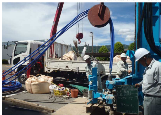
熱交換用パイプ挿入状況
