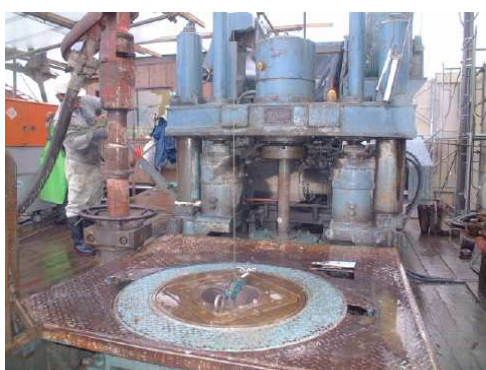
温泉掘削工事
